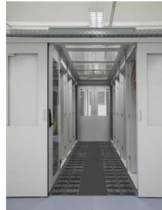
Swap Panel 9 Elemente bis 60% frei Fläche => hoher Luftdurchsatz
