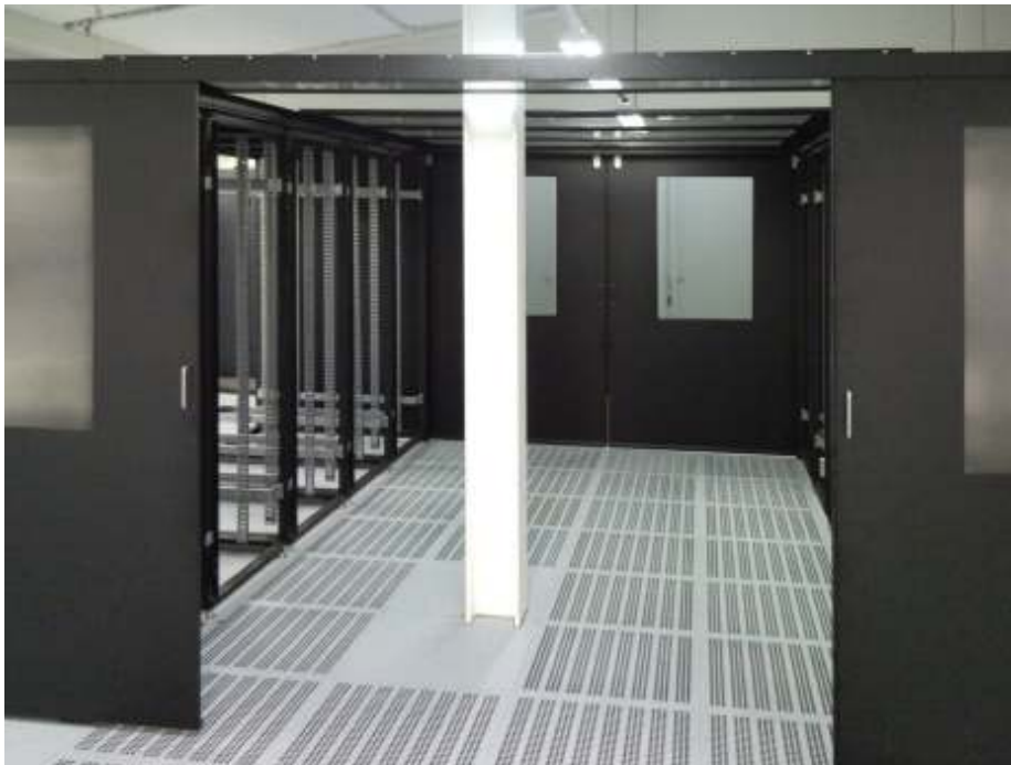
Herkömmliche Luftdurchsatzplatten Ca. 40% frei Fläche => geringer Luftdurchsatz
